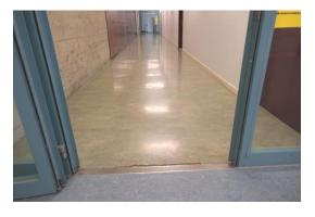
Einige Oberflächen (Bodenbeläge) haben ihre technische Lebensdauer längst überschritten. Mit einer Sanierung würde weitere Schäden und damit Kosten vermieden. Je länger, dass auf eine Reparatur verzichtet würde, desto tiefer werden die Furchen in den Böden und desto aufwändiger wird eine Reparatur zu einem späterem Zeitpunkt.
