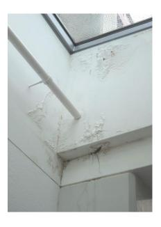
Acht undichte Oblichter auf dem Altbau wurden bereits ersetzt, jedoch ist auch bei den restlichen der Wassereintritt nur noch eine Frage der Zeit. Wassereintritt kann zu massiven Folgeschäden führen. Die Gebäudeversicherung bietet zwar Schutz bei Unwetterereignissen oder Leitungsbrüchen, aber nicht, wenn Schäden aufgrund von mangelndem Unterhalt entstehen.
